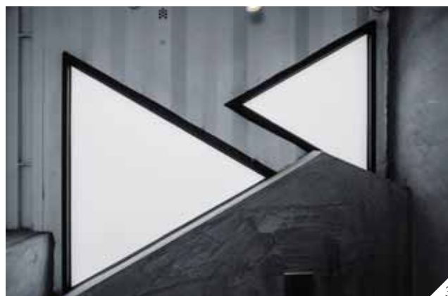
圖 3 氣凝膠複層玻璃，保有隱密性兼具高透光度與隔熱效果
