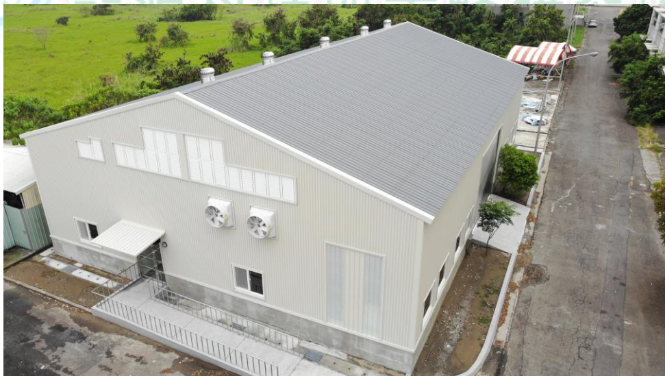
圖 4 600kW th 雙流體化床生質氣化爐示範平台
