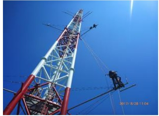
圖：離岸風場之海氣象觀測塔
