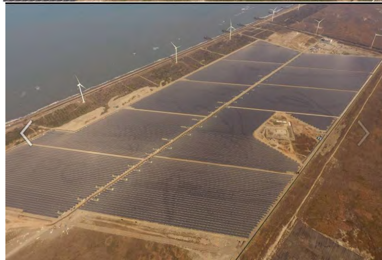
台電公司彰濱工業區崙尾西區光電， 設置容量100MW，面積約150公頃。
